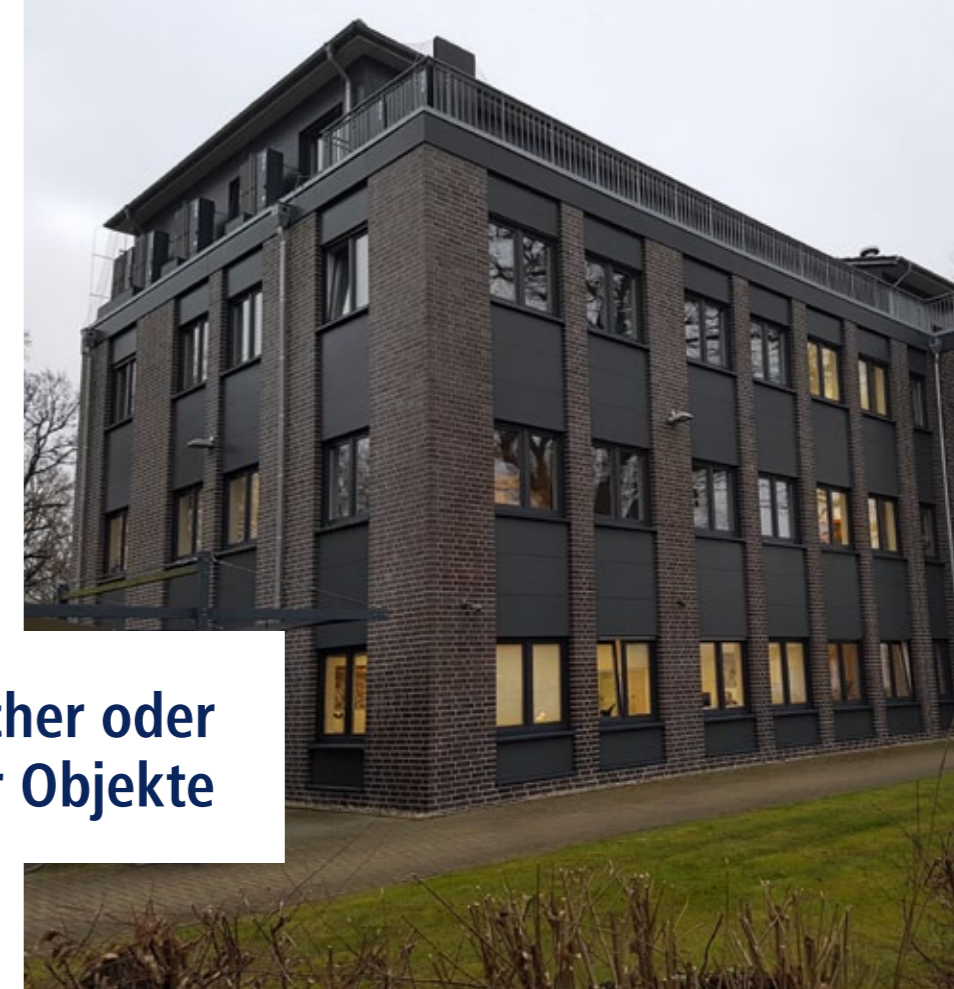
OL-Ofenerdiek, Verwaltung eines Bürohauses
