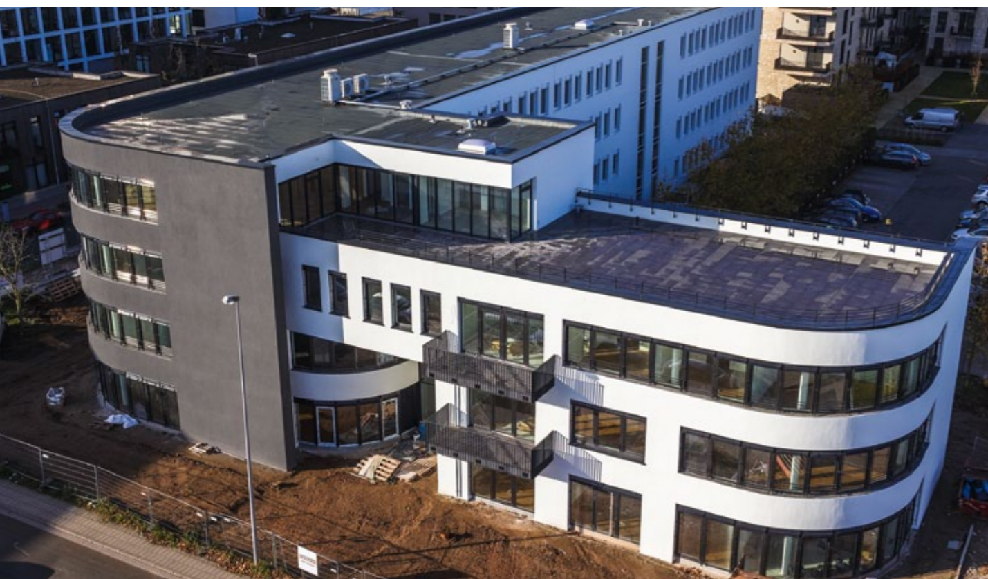
Bremen, Verwaltung eines Neubau-Bürohauses
